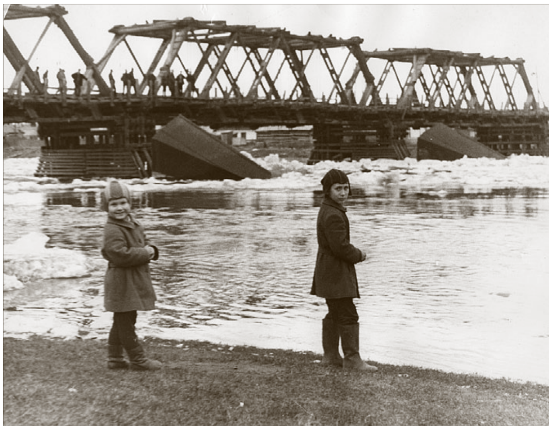
Весна 1971 года. Последний ледоход под деревянным мостом с волнорезами-«быками» через реку Ухту. Фото Сергея Карпова.
